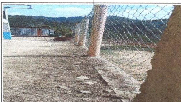
Foto 4: Reparación de muro perimetral de block con tubo hg y malla galvanizada
