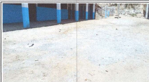
Foto 2: Sustrucion de torta de cemento
